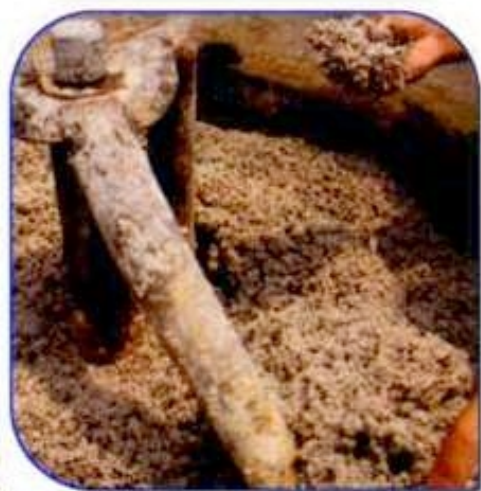
拌和保温材料形成粘稠浆料
