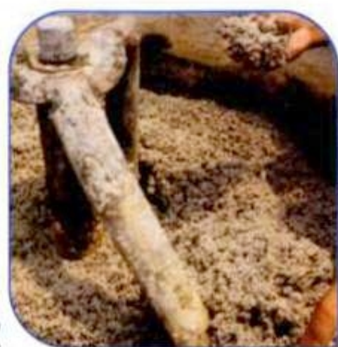
拌和保温材料形成粘稠浆料
