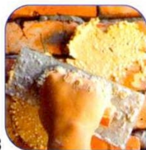
坯刮保温材料上墙
