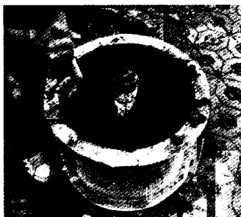
图 3 砌筑水泥基座
