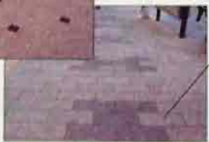
花岗石路面铺装实例 注:应考虑防滑, 室外地面石材均须为毛面, 不宜磨光。
