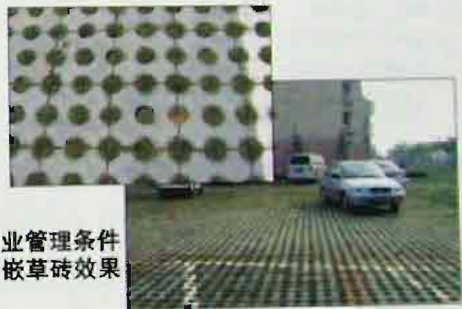
2 嵌草水泥砖路面做法 (适用于小汽车停车场)
