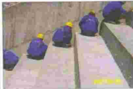
基层处理（二） 奥体中心看台
