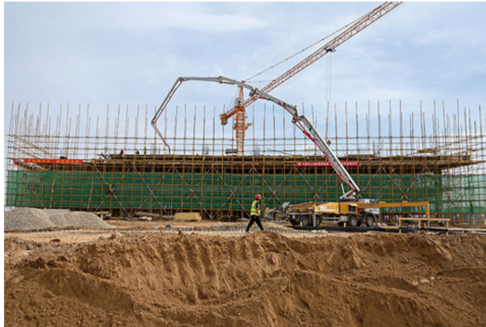
2022年7月15日，太原，一处大型基建项目建设工地。7月以来的稳增长政策措施加码，旨在扩大有效投资。图：韦亮/中新社
