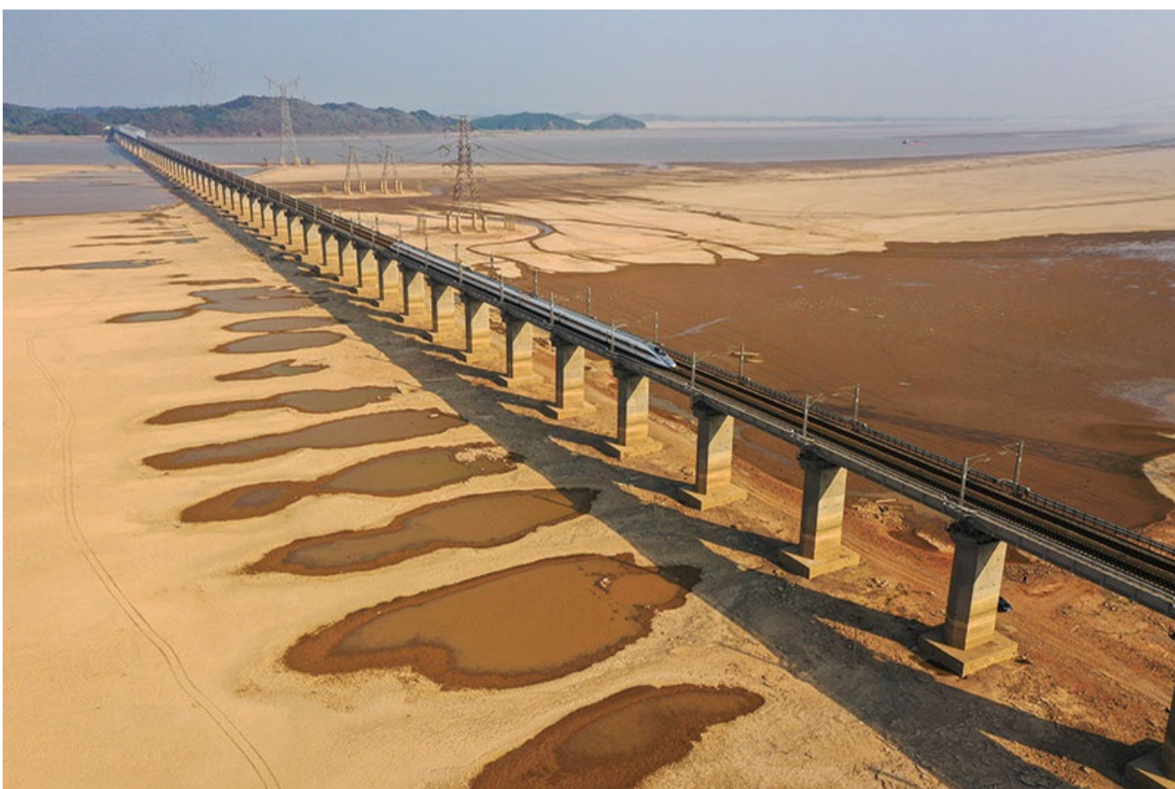
2022年8月24日，江西九江，鄱阳湖濂溪区牛头山附近水域，衢九(九景衢)铁路高架桥下，湖区干涸见底。
