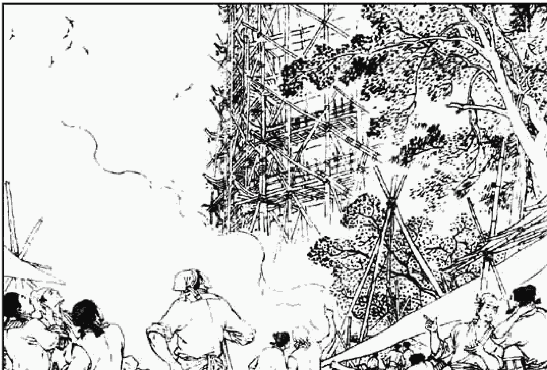
(46) 塔身上升到七八层时，肉眼已看得出塔身倾斜。有的工人怕在施工中塔身倾倒，造成伤亡，竟不敢上去工作。
