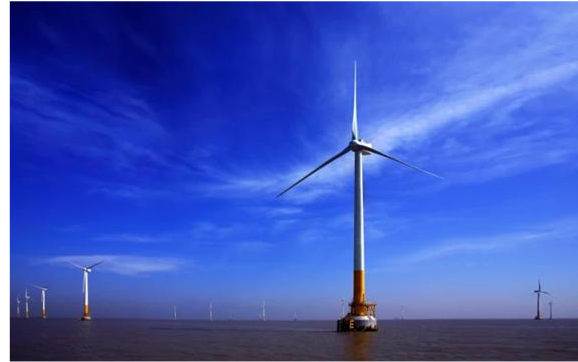
图 35:公司承建的亚洲首座海上风电场-东海风电一期
