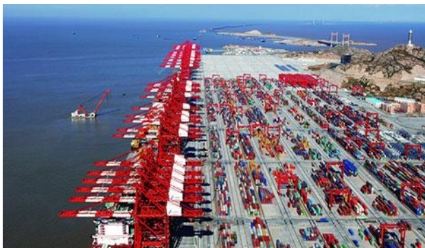
图 9:代表性工程-上海洋山深水港区工程
