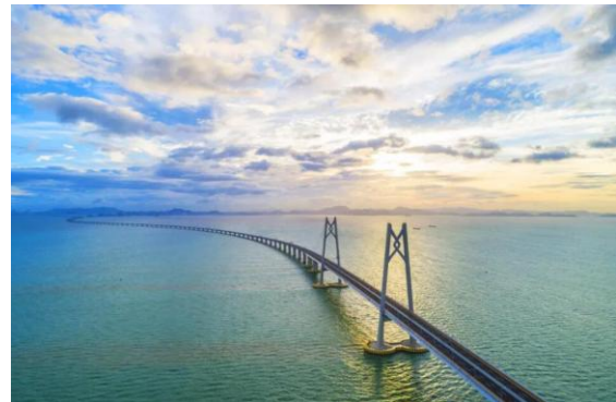
图 10:代表性工程-港珠澳大桥
