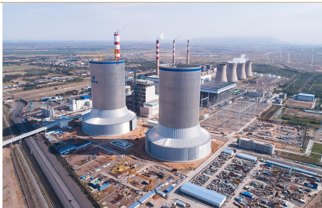
图 12：华能宁夏大坝电厂 2x660MW 一机一塔间冷钢塔项目
