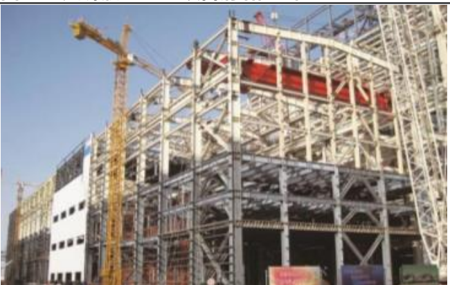
图5：公司案例 c-工业项目钢结构工程
