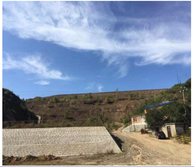
图 56: 内蒙古金淘二道沟矿山二号尾矿库
