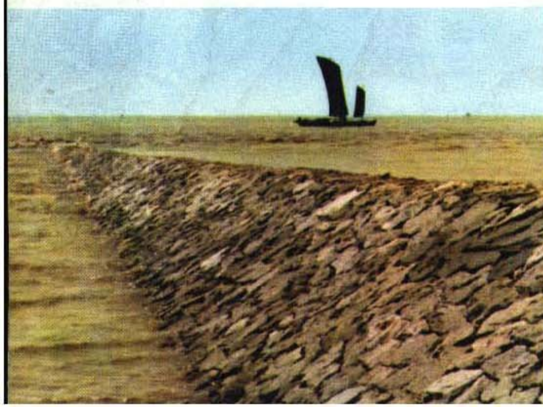
深入江海中的丁字坝，护卫着崩坍地区的大堤。 上海电影厂 供稿
