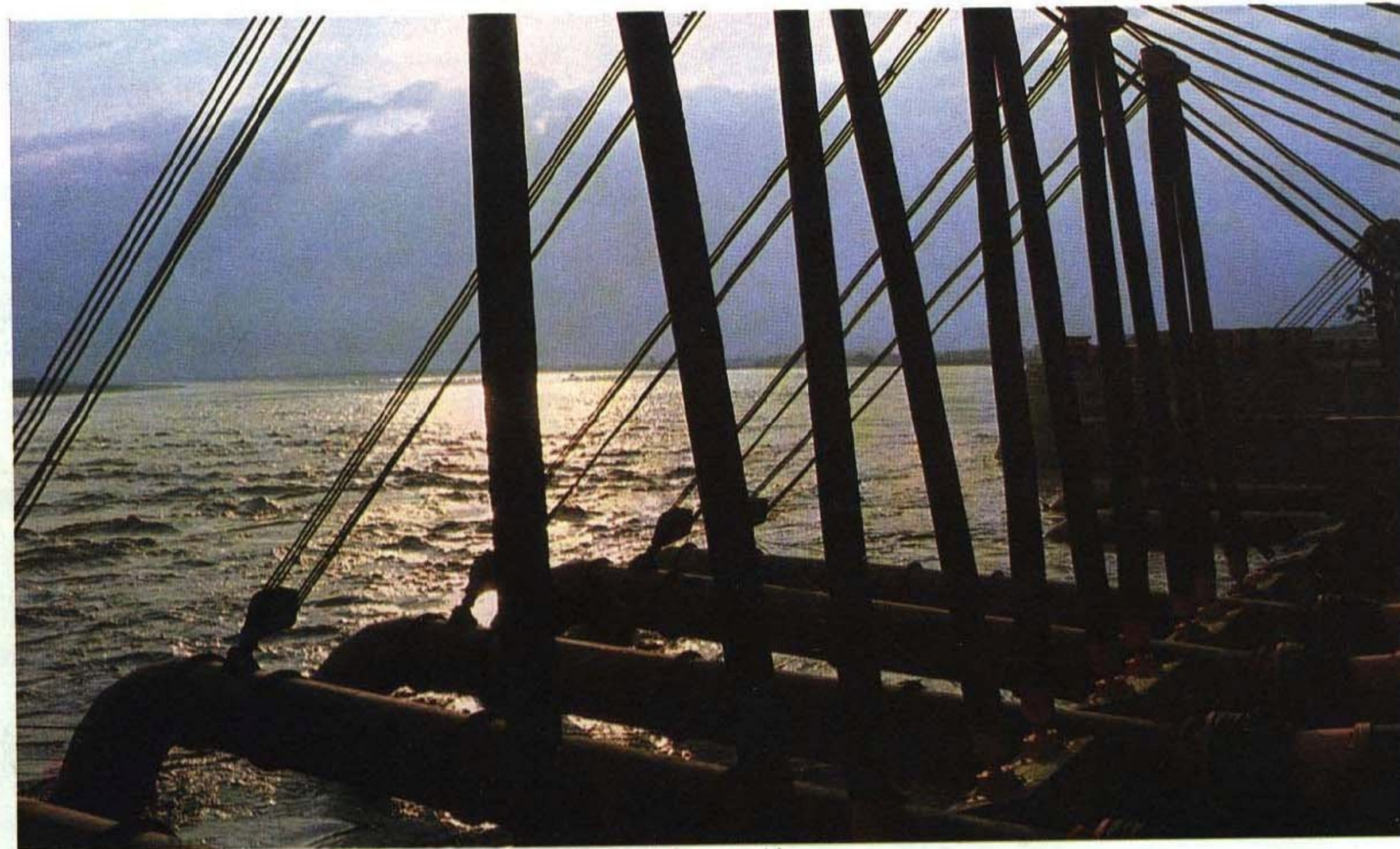
沿河兴建的虹吸工程之一。
