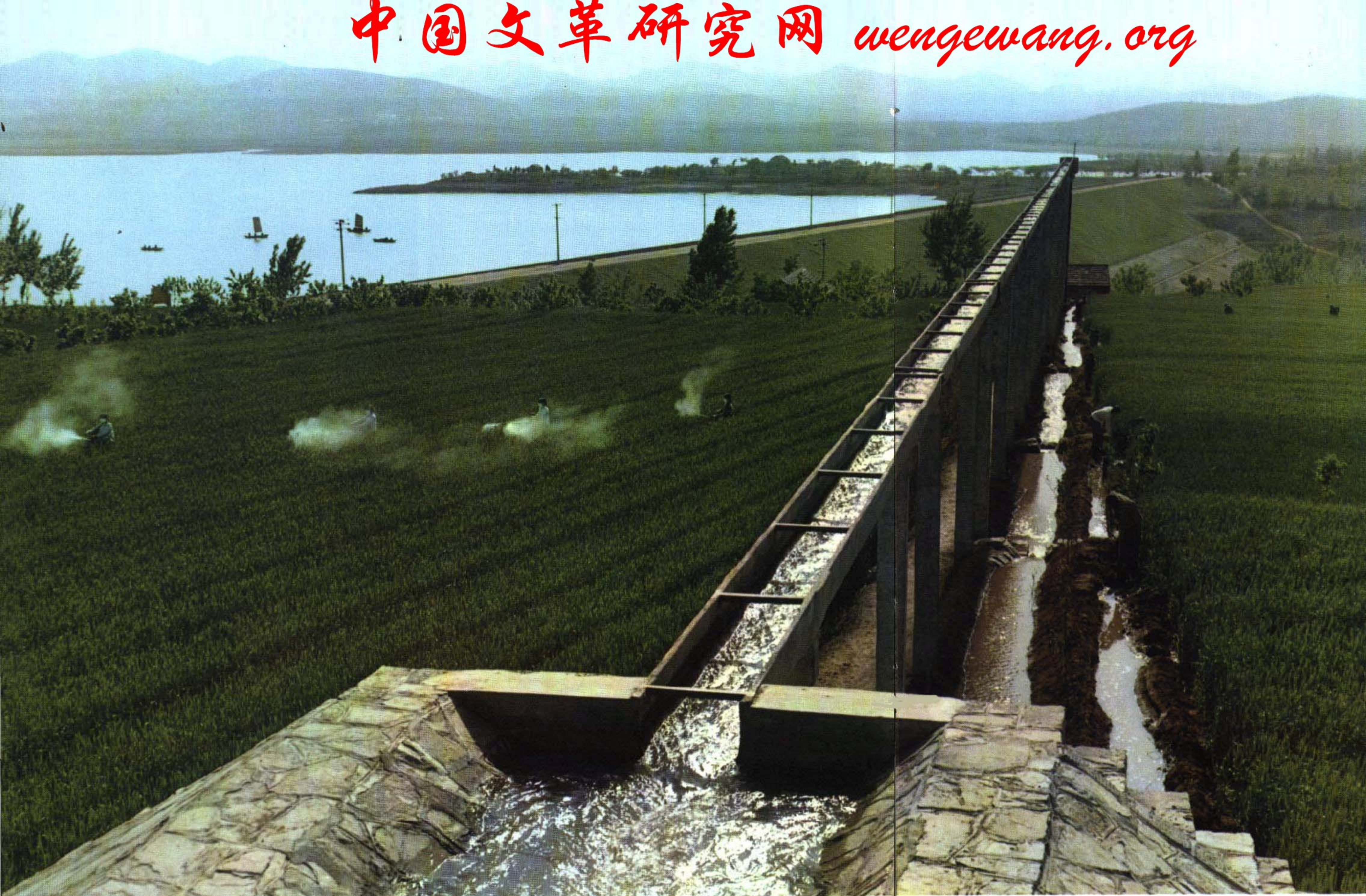
冶源水库的部分灌溉区。这座水库是一九五八年动工兴建的。
