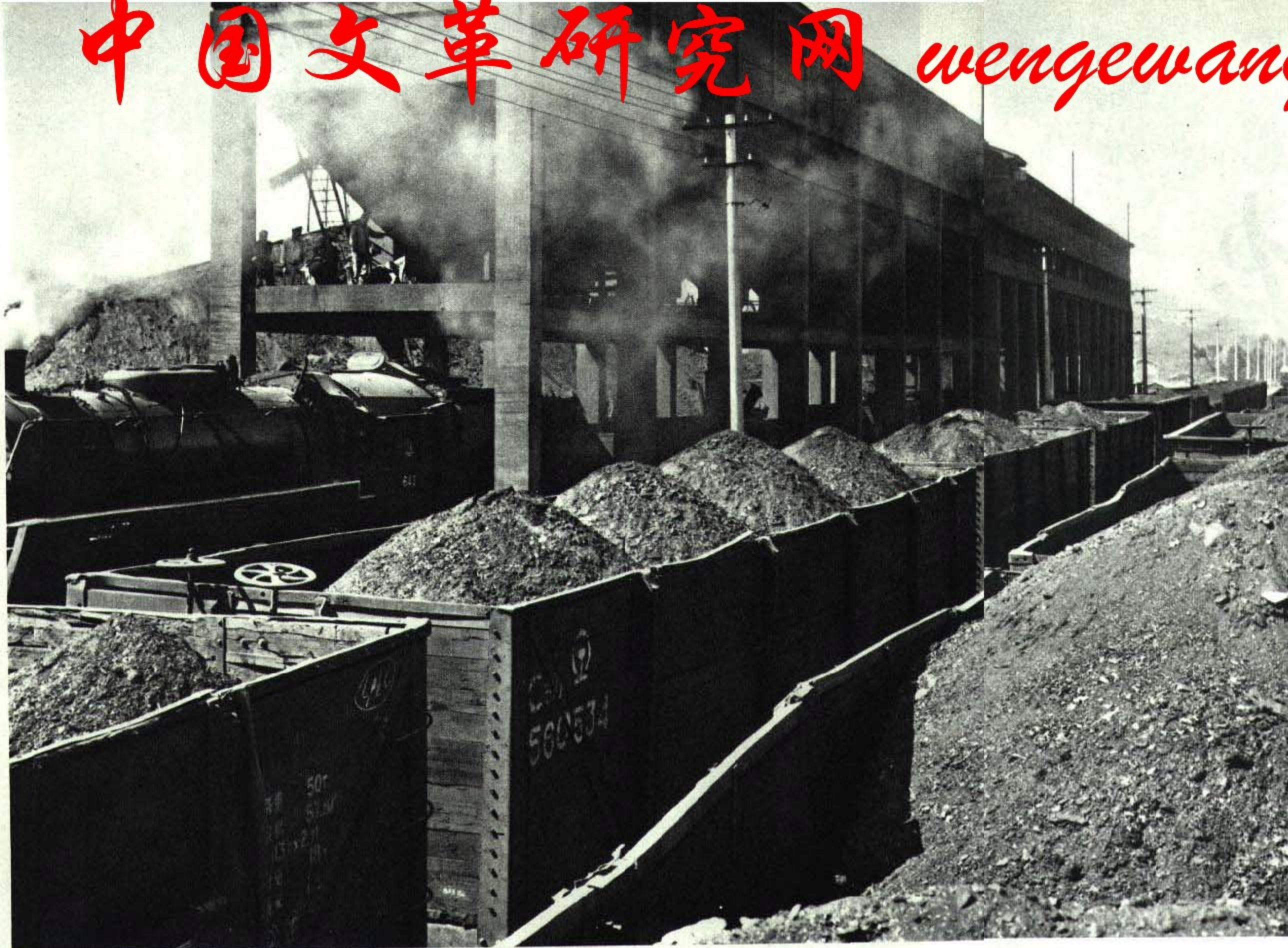
在长期被认为少煤的江南地区，我国地质工作者找到了一些具有工业开采价值的煤田。这是福建邵武煤矿的煤炭装车外运。 新华社记者 摄影
