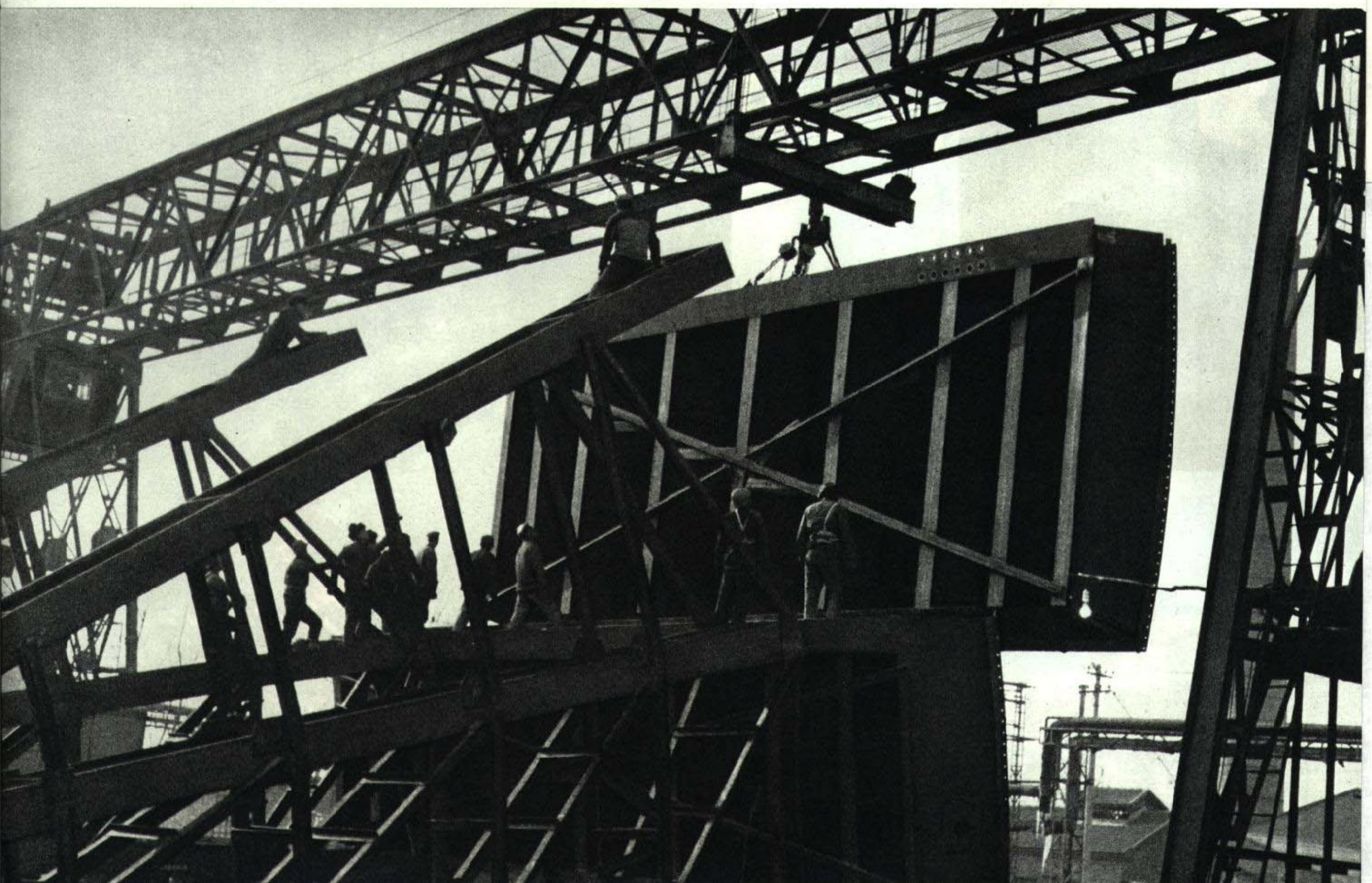
每台重一百二十吨的闸门试行组装。
