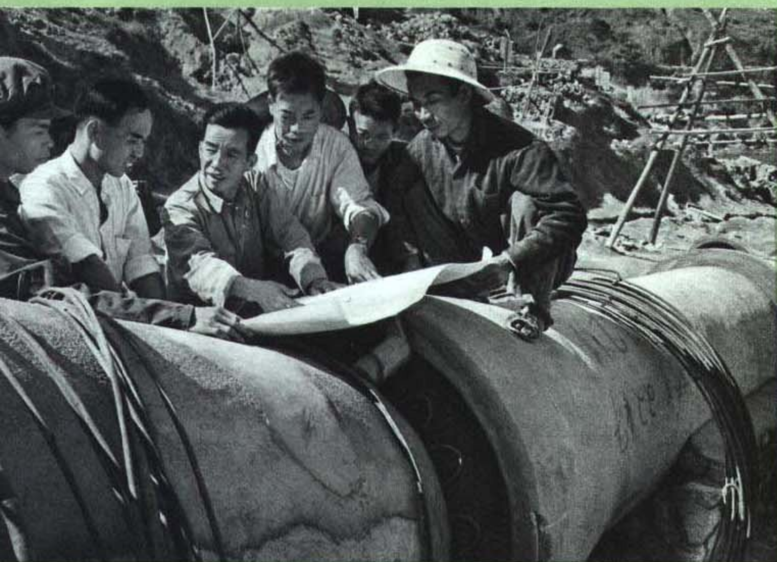
活跃在水电站工地的一个“三结合”技术小组。
