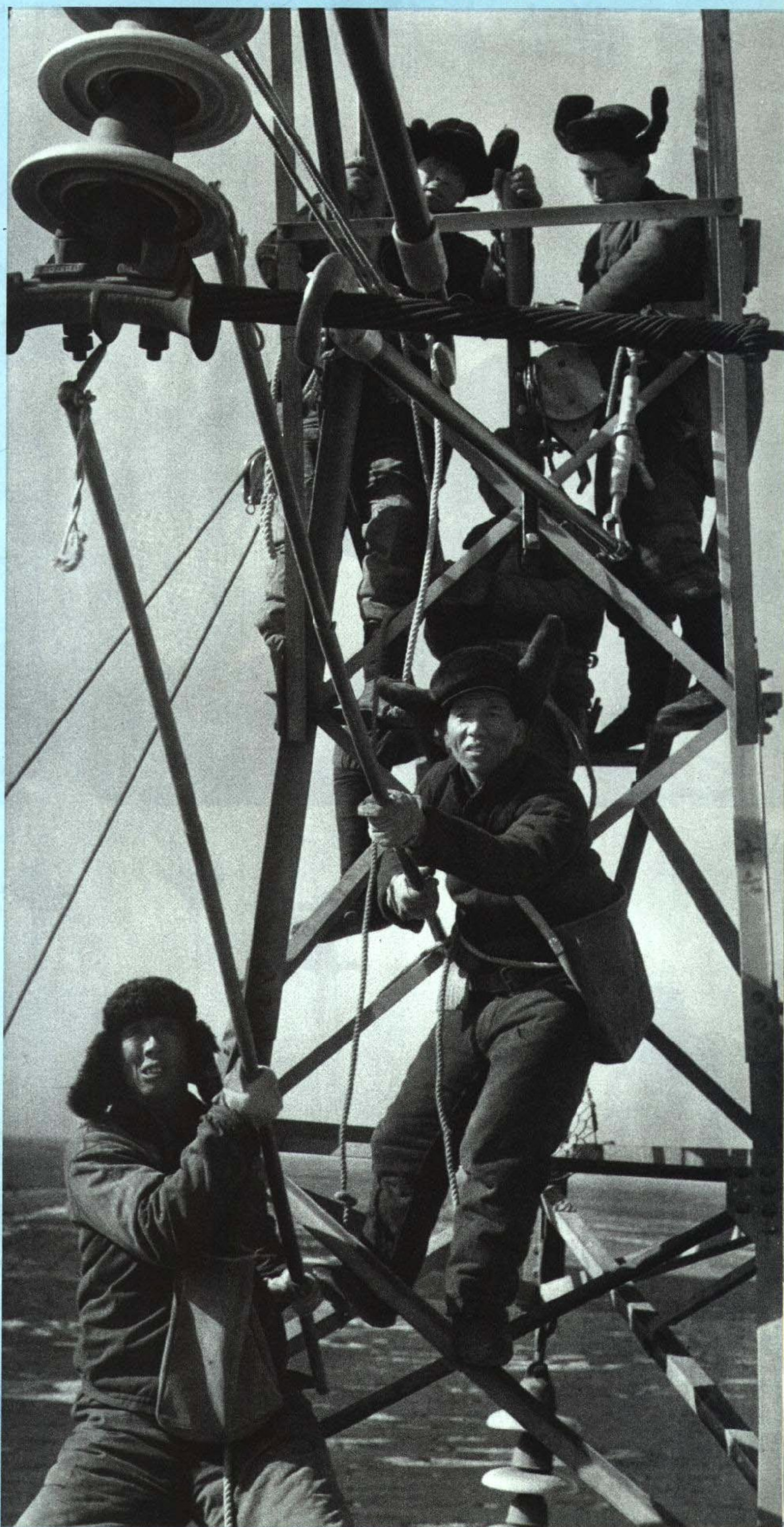
郑代雨和工人同志一起参加超高压线路带电加高塔头的高空作业。
