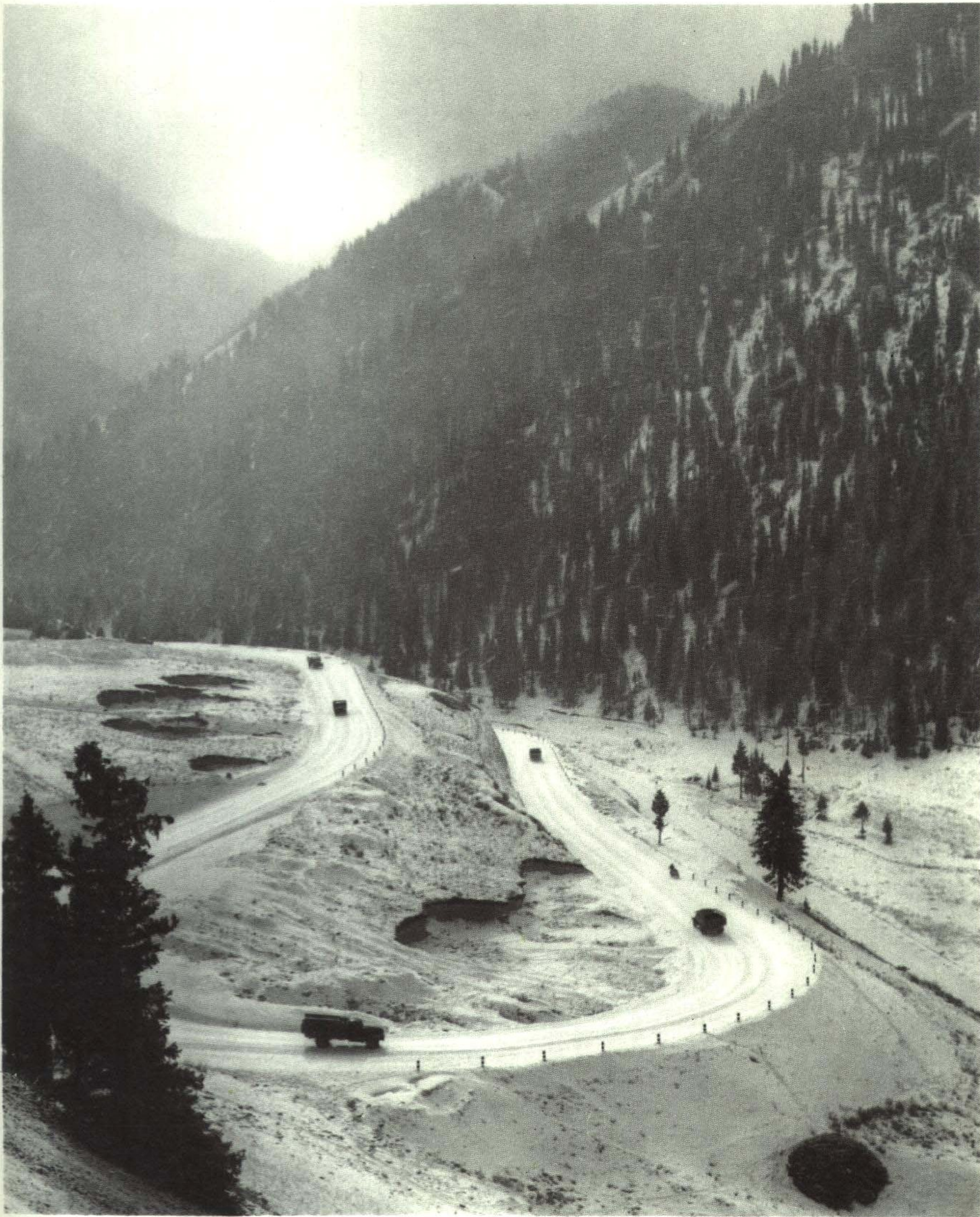
在新疆维吾尔自治区的天山，养路工人们常年坚守岗位，为社会主义建设辛勤劳动。每当冬季，他们与风雪搏斗，在崎岖的山上精心地养护着公路，保证来往运输车辆畅通无阻
