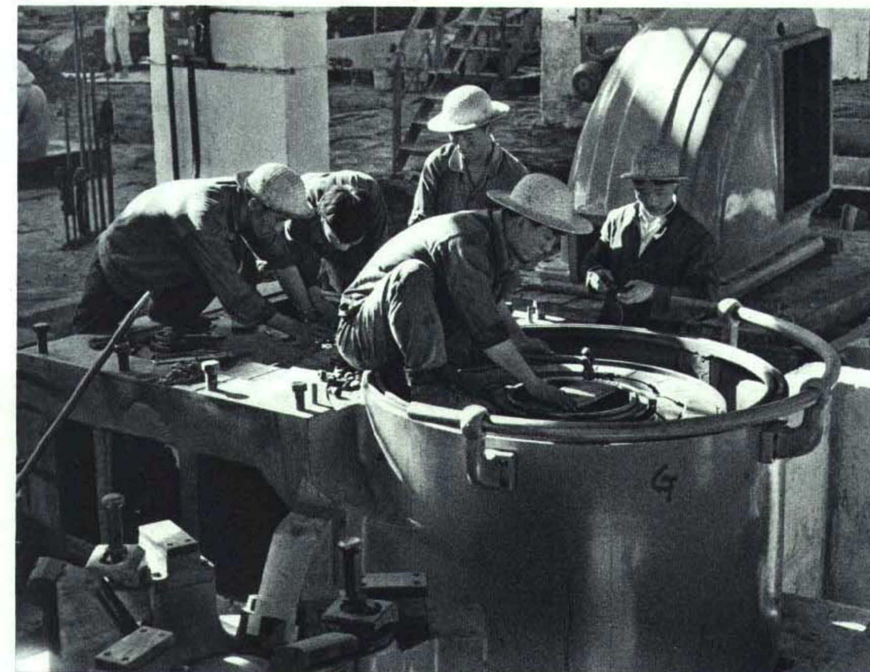
安裝加工車輪用的大型立式車床
