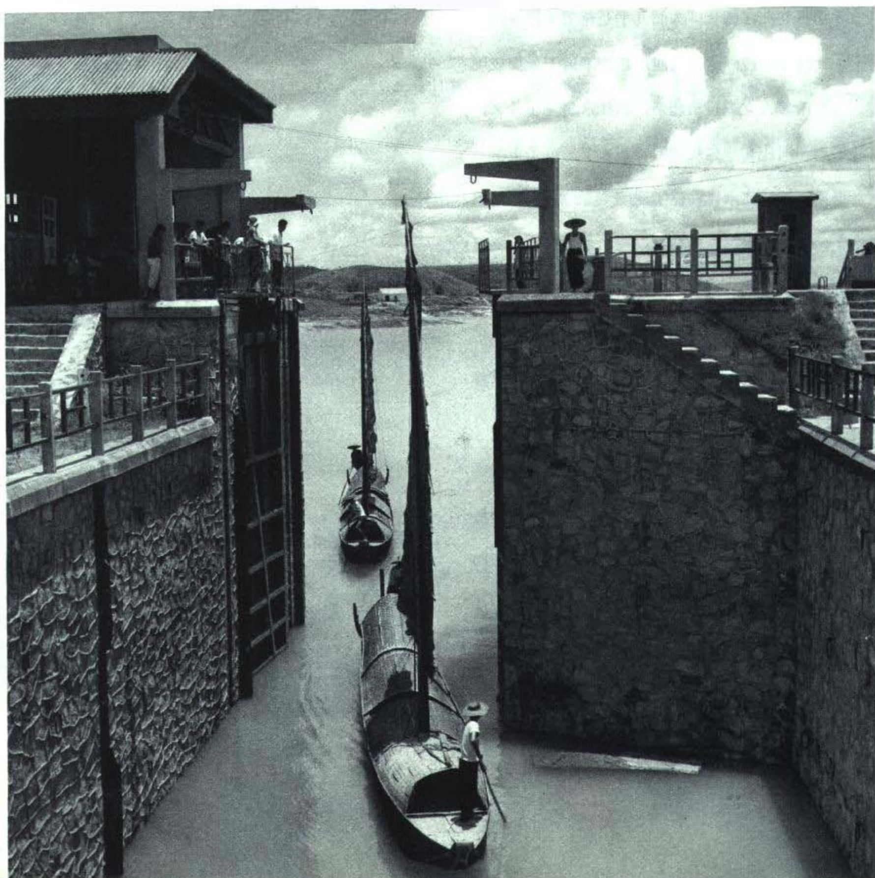
青年运河渠首工程的船閘
