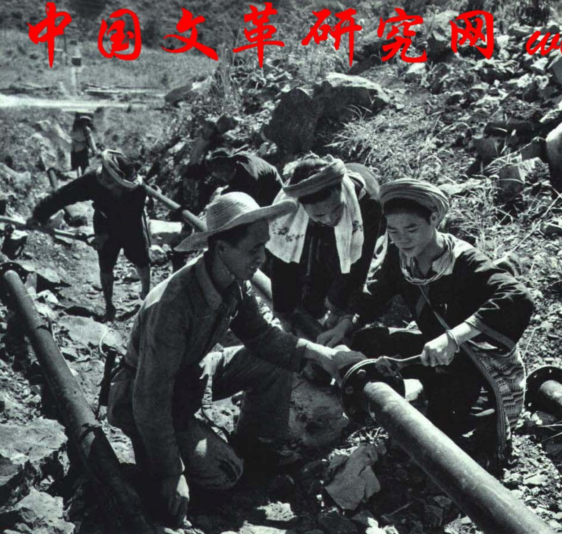
住在高山上的三排公社三排大队，兴建电动抽水工程，改变缺水状况。图为汉族技术员正在同瑶族社员一起安装水管
