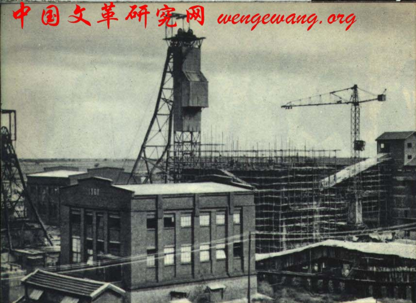
又一座大型煤矿井在建设 一座年产一百八十万吨的大型矿井——河北开滦煤矿范各庄矿井，正在加紧建设。目前，地面建筑已接近完成，工人们正在加速开拓井下运输巷道，积极准备采煤工作面。 时盘棋摄影
