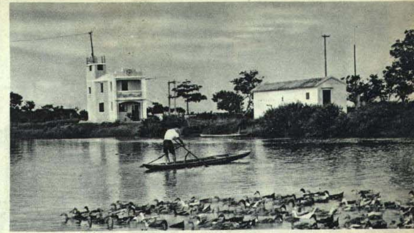
大队近两年增建的三座电力排灌站之一(右)。为了适应用电量的增长,最近又新建了变电站(左)
