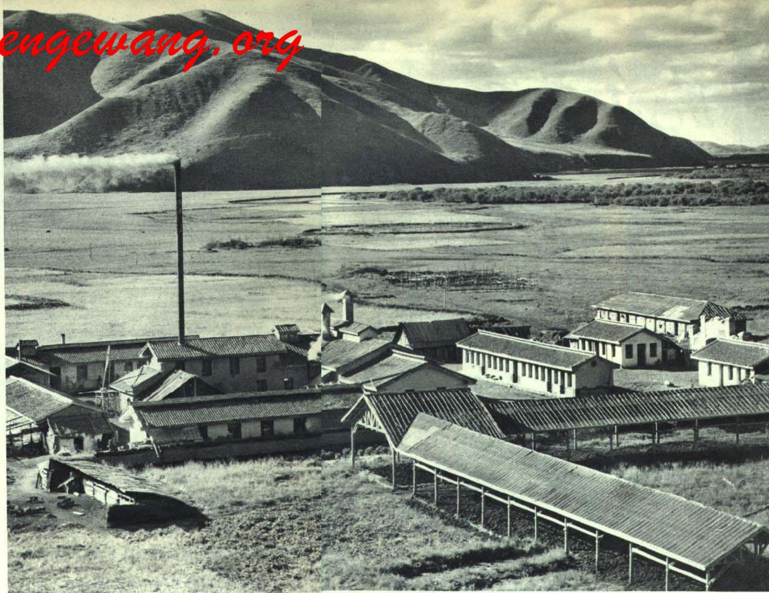
阿壩地区从前根本没有工业，现在县县都办起了农具厂，很多县还办起了榨油厂。图为自治州新建起的年产两百吨的奶粉厂
