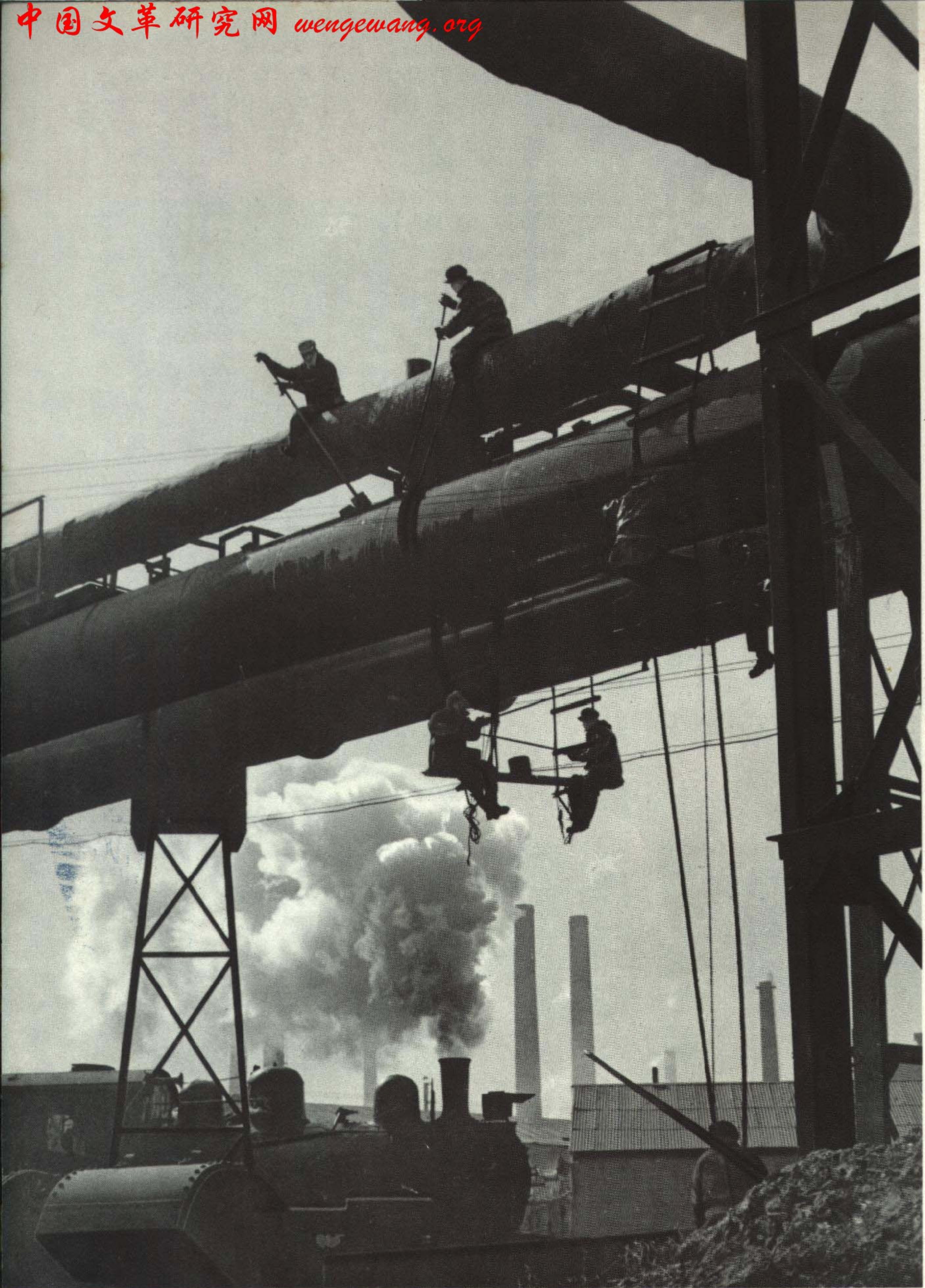
檢修煤氣管道
