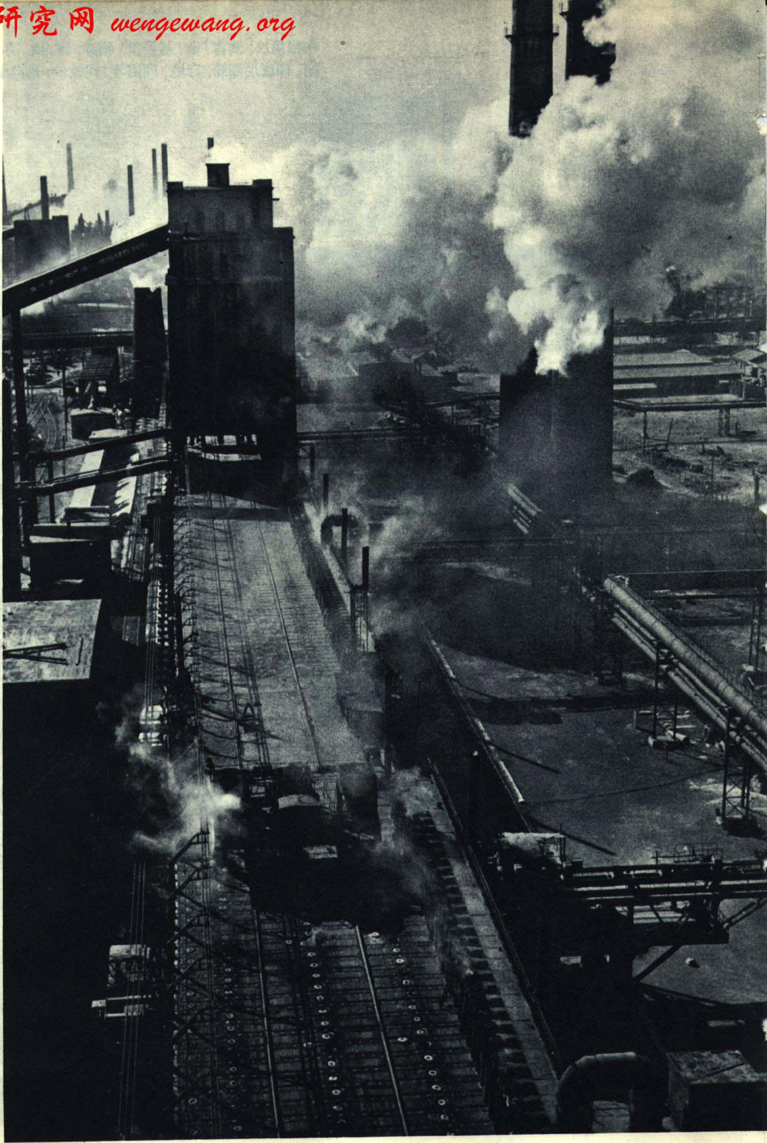
生气勃勃的鞍山钢铁公司。这是化工总厂的炼焦炉
