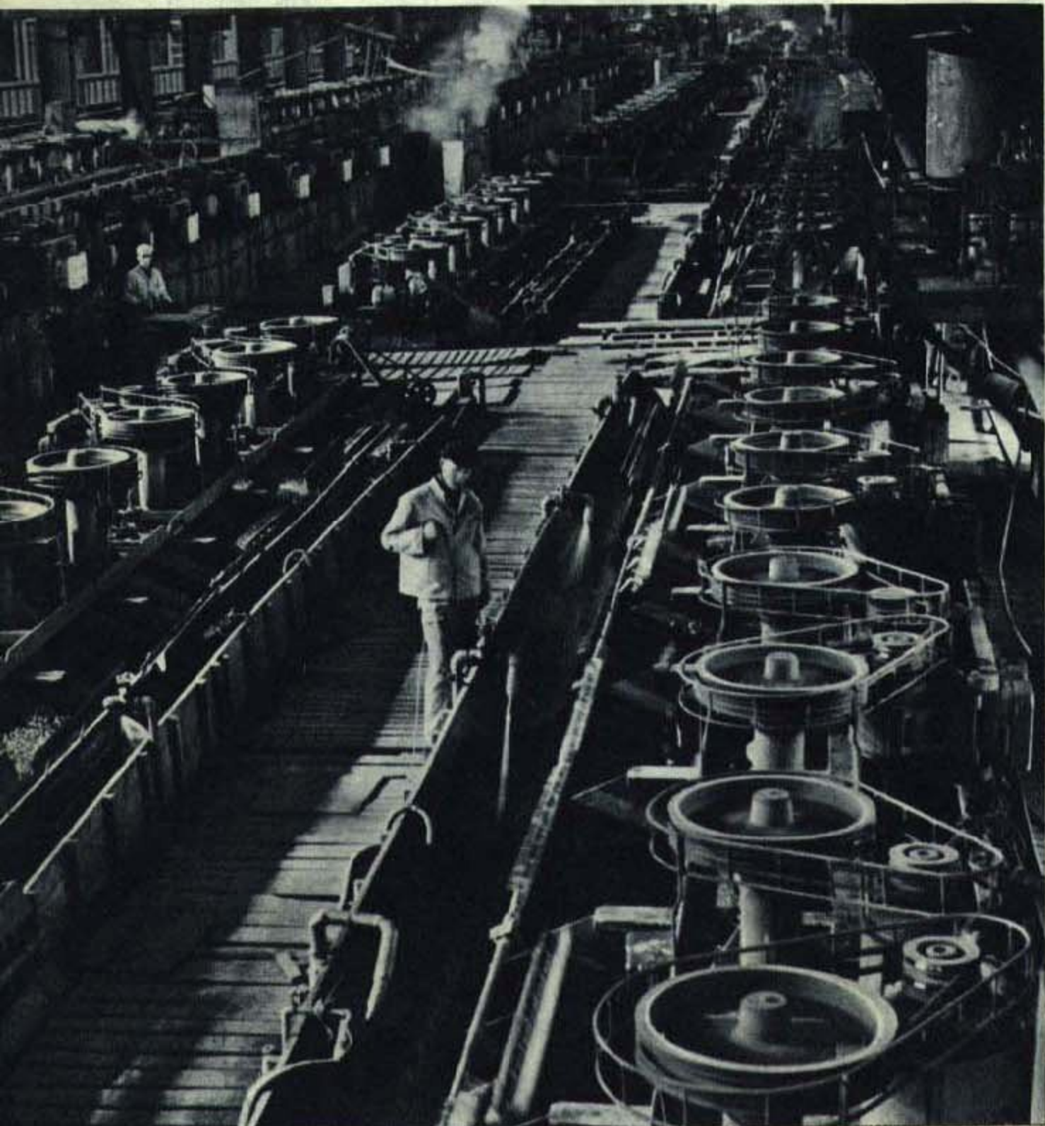
选矿車間的工人們正在为高炉准备“細粮”——精矿粉
