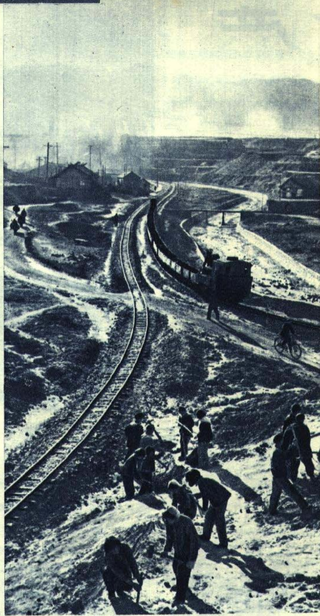
山东省淄博市交通运输部门职工，一年多来兴建了23条地方铁路，有力地支援了钢铁生产 张书水摄影
