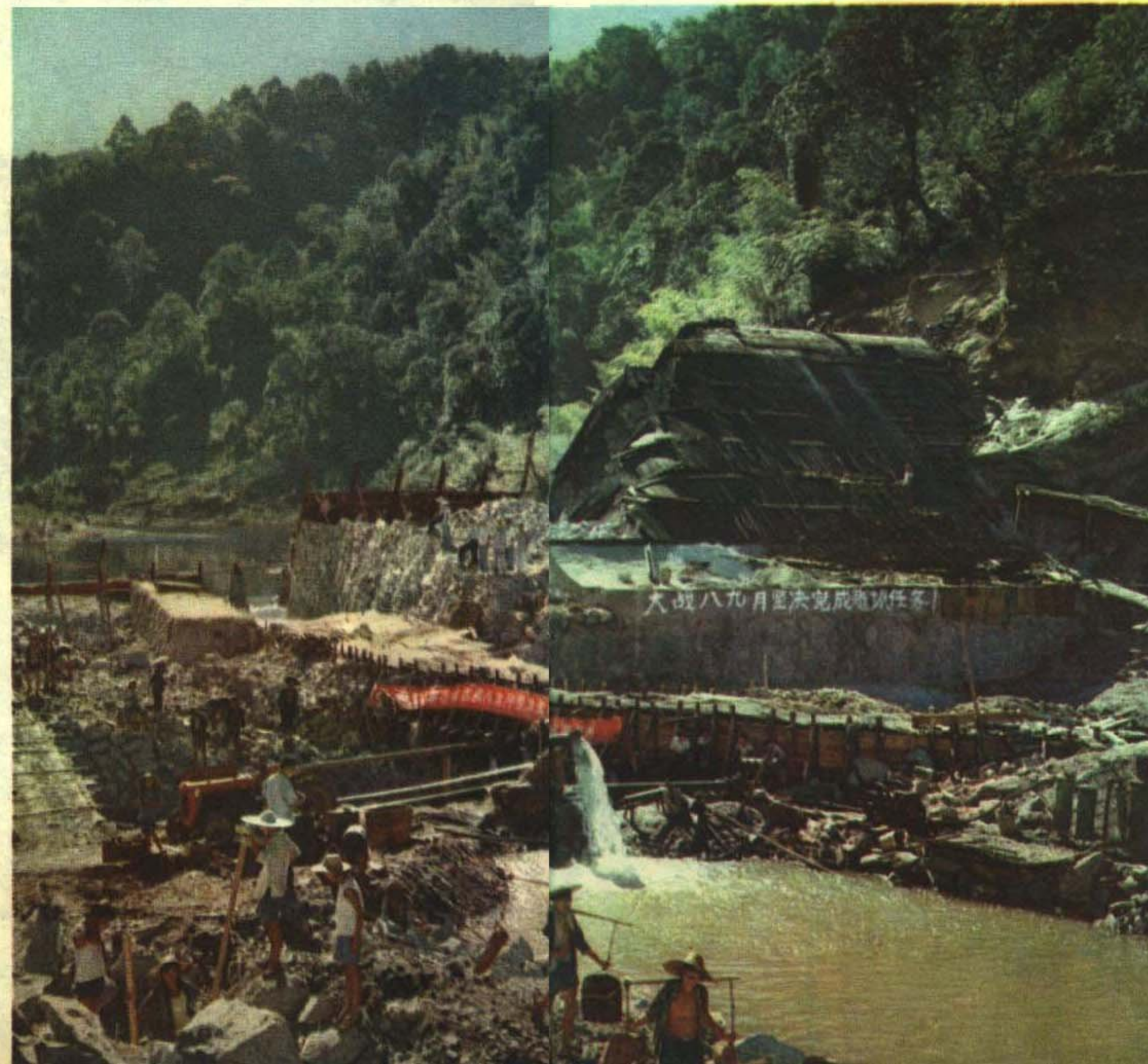
正在兴建的水电站
