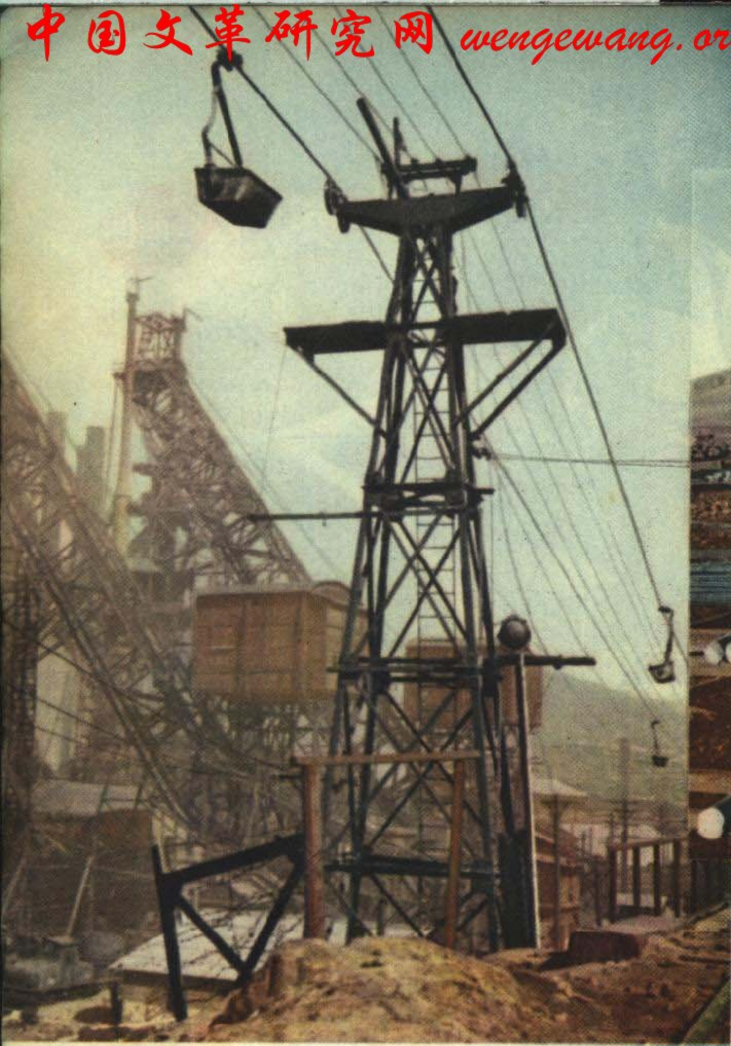
本溪是一個出煤出鐵的城市，附近埋藏着豐富的礦產。滿載石灰石的吊斗，可以由採石場沿着高架索道直接運到煉鐵廠。
