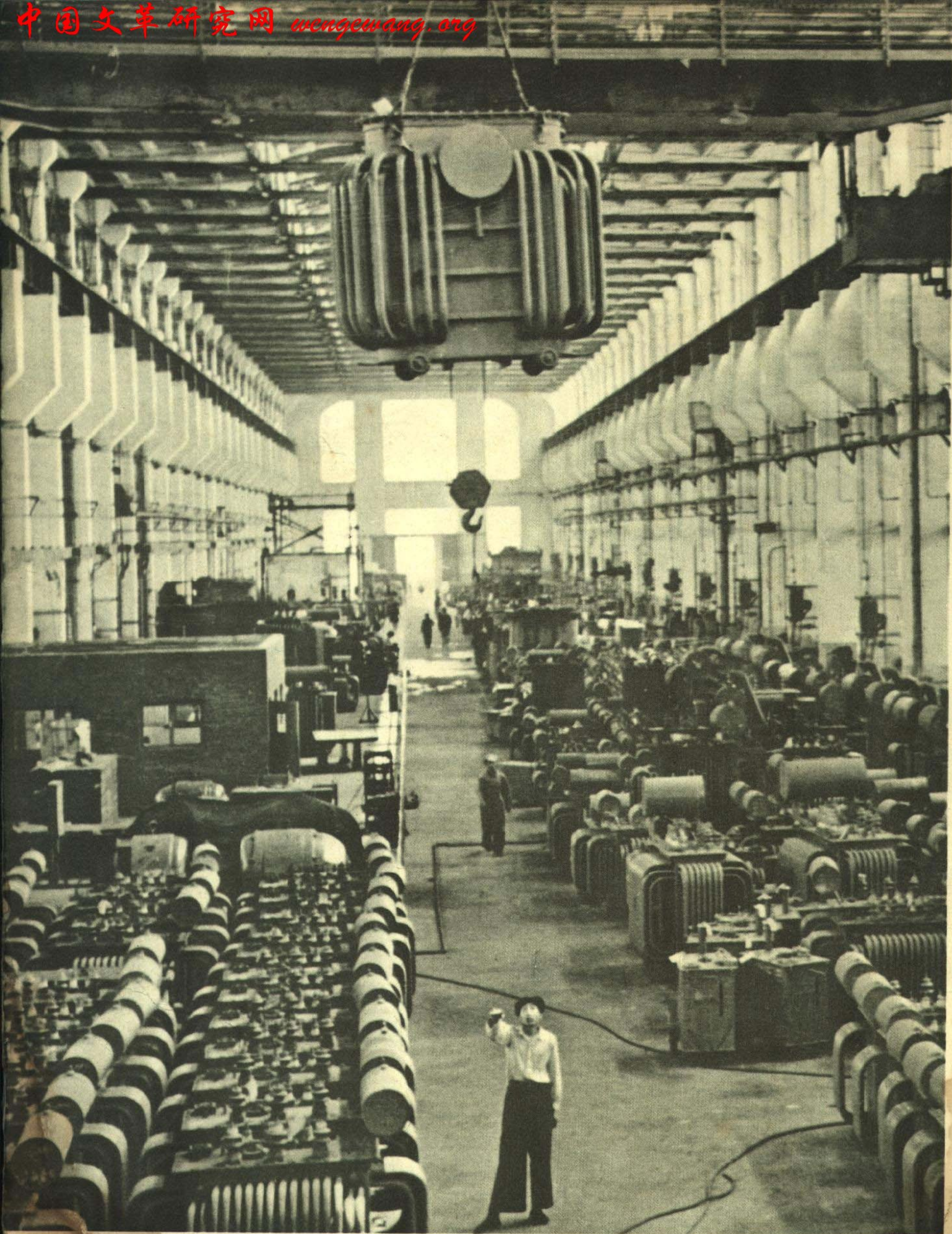
瀋陽變壓器廠製造的礦山用和試驗用的變壓器。這些變壓器都是我國過去不能製造的。 新華社攝影部記者張瑞華攝影
