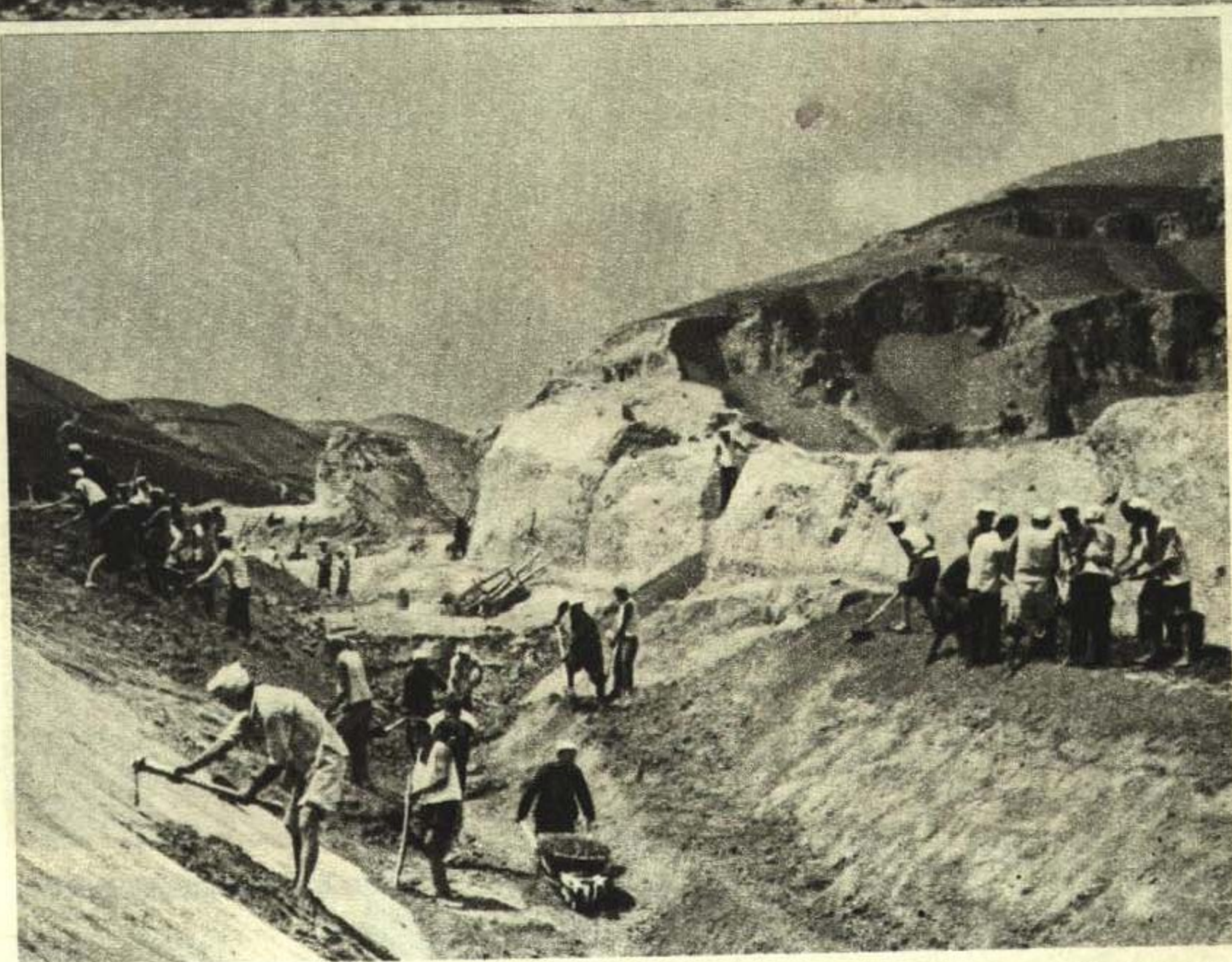
在西北黃土高原地帶黃河中游的支流上，展開了築壩淤沙的水土保持工作。
