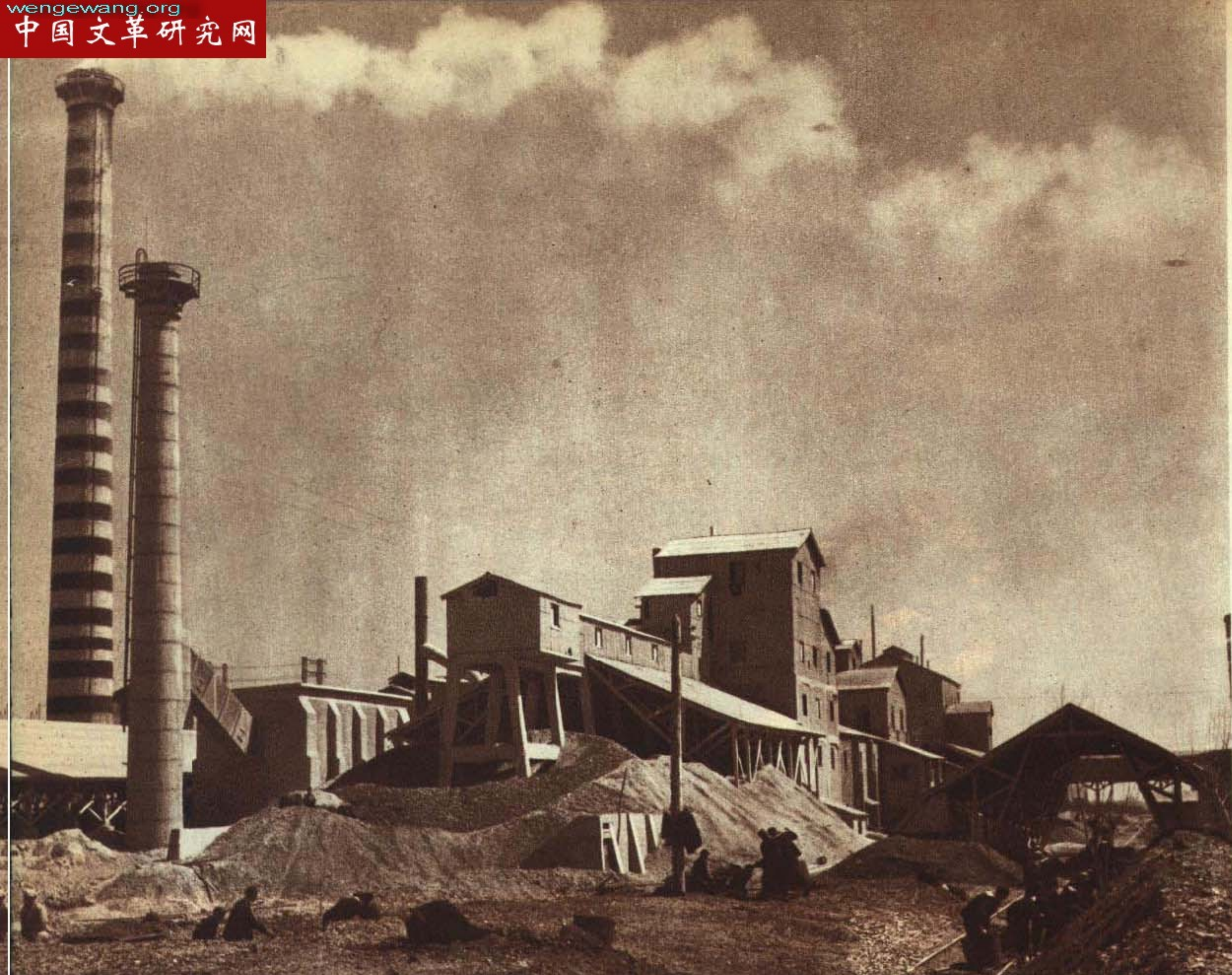
在錦西第五水泥廠的原料場上堆滿了製造混合水泥的原料。
