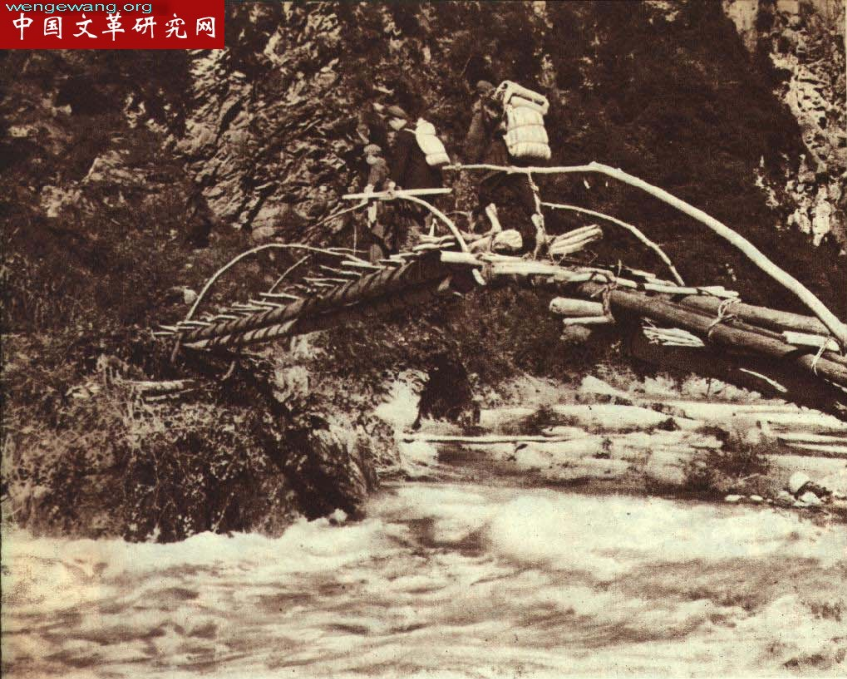
西南森林調查隊赴四川北部某林區調查。沿途經過拔海四千公尺的高山，跋山涉水非常艱險。在這裡，隊員們正慢慢地走過臨時搭起來的便橋。
