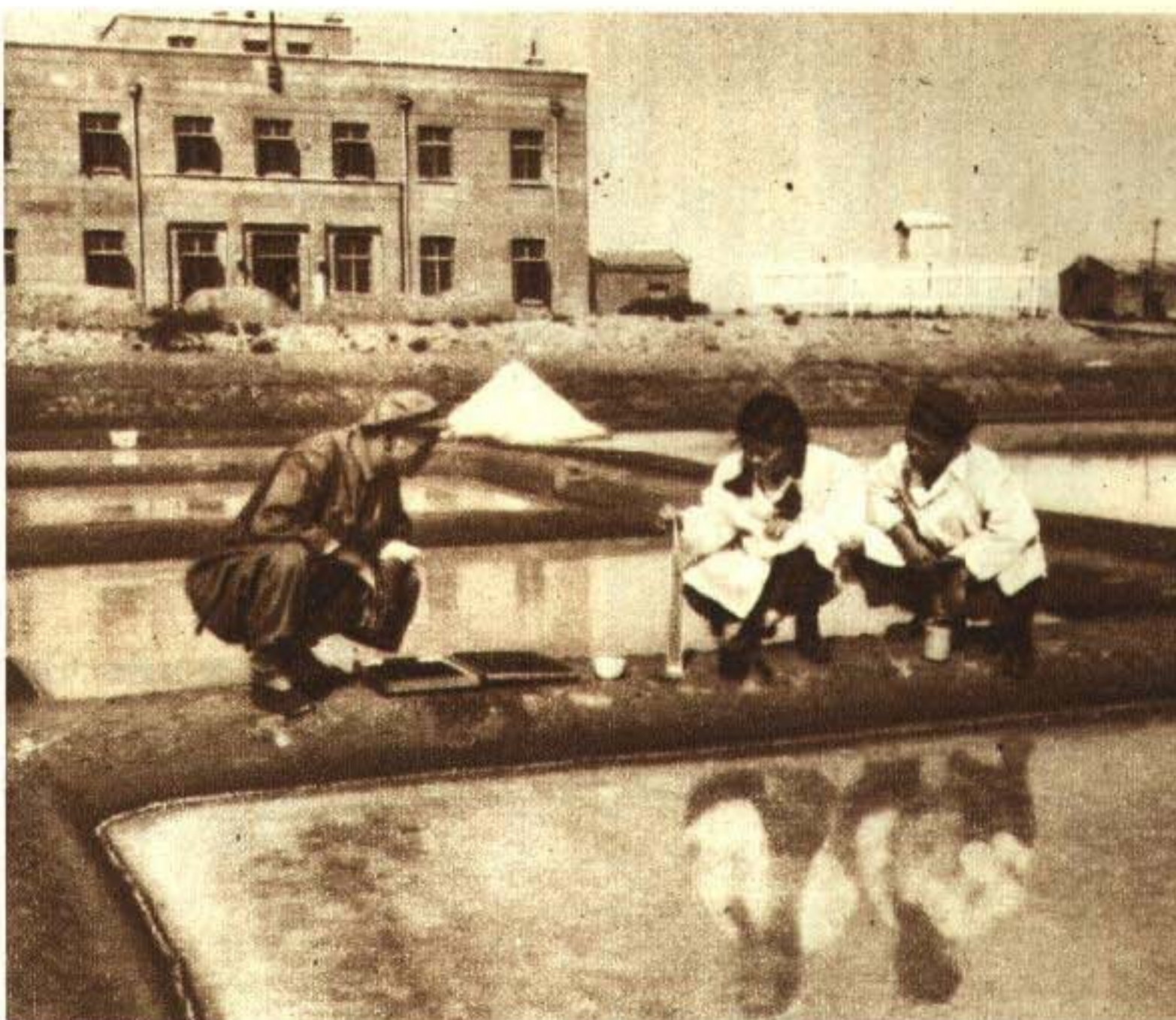
場內開闢了許多試驗池，池板有用水泥做的，有用水板做的，有用鐵板做的，也有用蘆席做的。化驗員正在檢查滴水的濃度，看那一種池板易於結晶。
