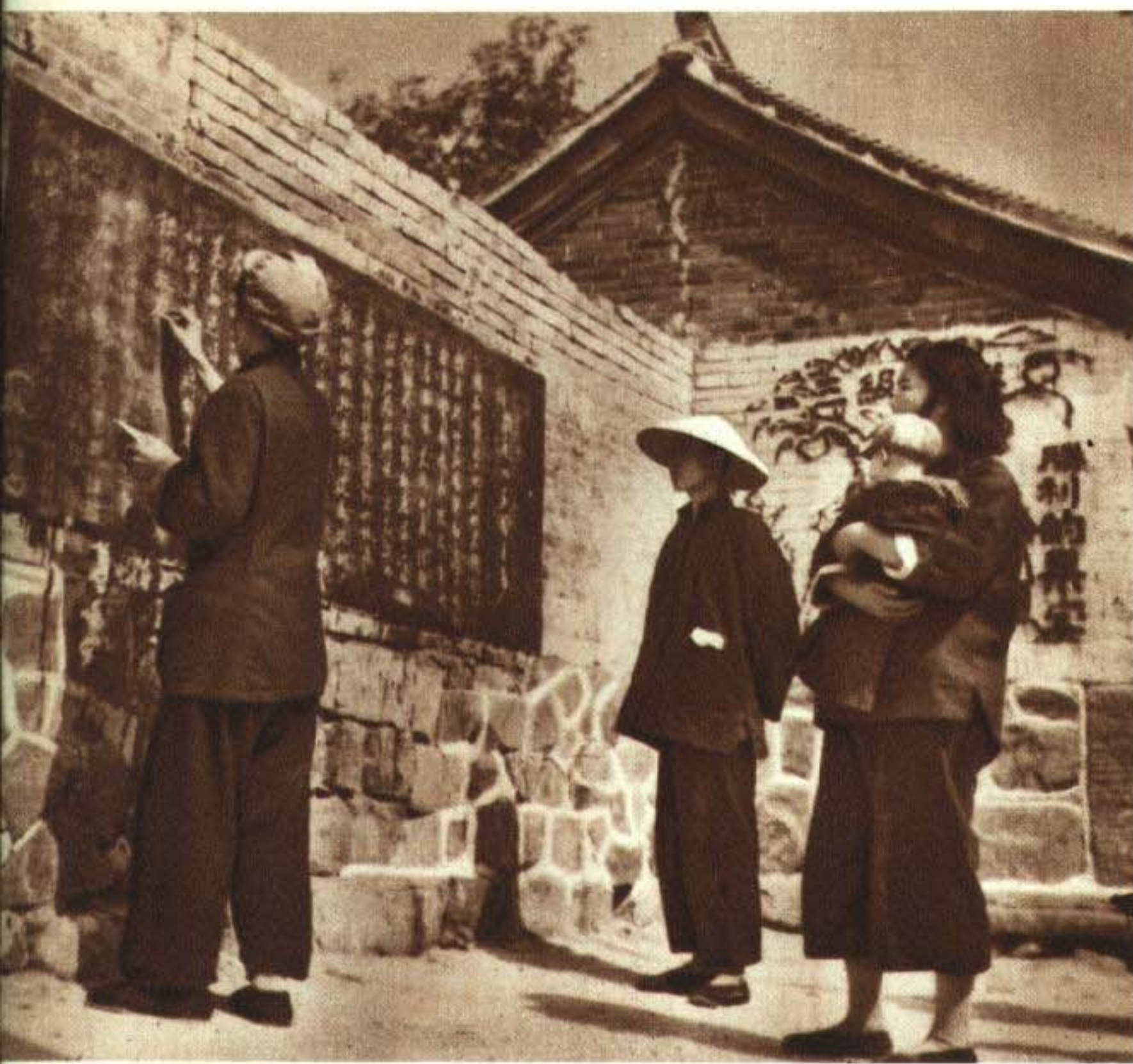
泥井鎮的收音員除組織村民收聽各種廣播節目外，還把重要的廣播內容記錄下來，寫在黑板上，讓當地村民都可看到當天的國內外的重要消息。目前這種黑板報已成為在農村傳播廣播消息的重要方法之一
