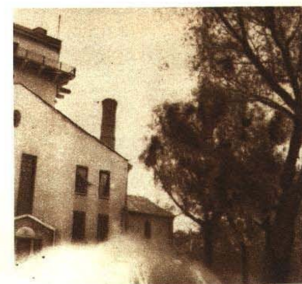
這是中央人民廣播電台新建的供給短波廣播發射機冷卻用的噴水池
