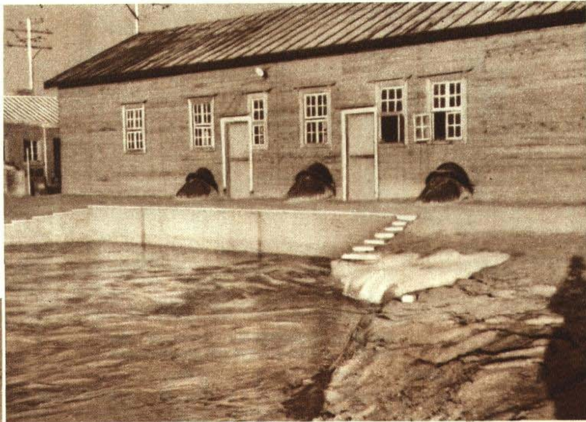
當潮漲的時候，海水湧進引水溝，在水溝盡頭裝有巨大的電動揚水機（在屋內），它把大量海水抽進汪子來
