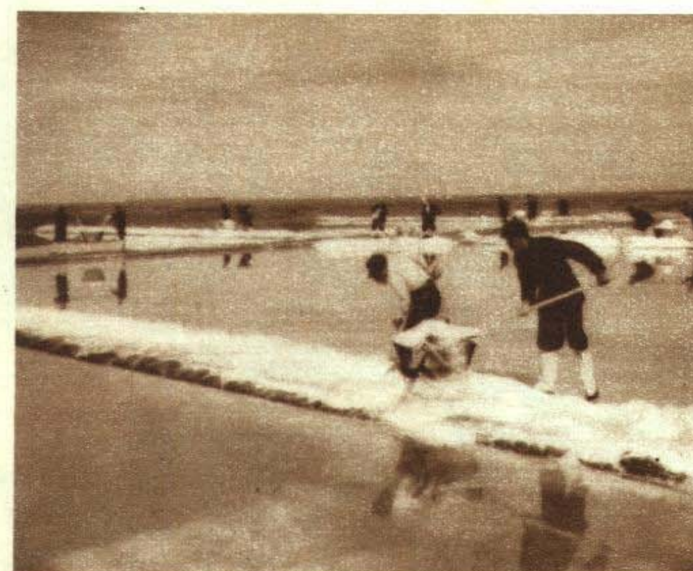
池道扒鹽——從破礮開始，經過攪荒、歸堆而至灘地是目前一些鹽場所習用的較保守的扒鹽方法。大沽鹽場今年已開始採用大清河與漢沽鹽場的進步經驗，改用池道扒鹽方法，即在破礮後，直接把鹽扒上池道去，這樣可以節省三分之一的勞動力，減少了對池板(池底)的破壞，表土不易揚起，鹽質更加潔白；同時，不在池內停放，既可減少下雨沖洗的損失，還可提早換滷，增加結晶的次數。
