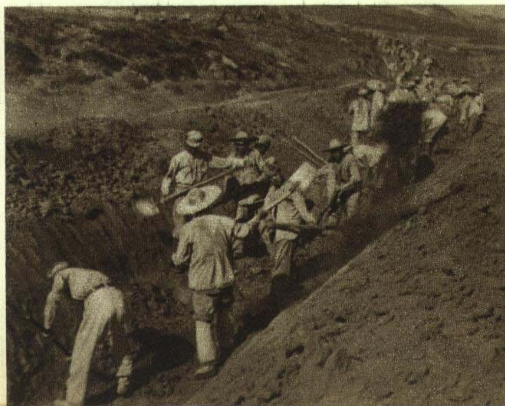
駐甘肅的人民解放軍某部修築古豐渠。圖為挖土方部份。
