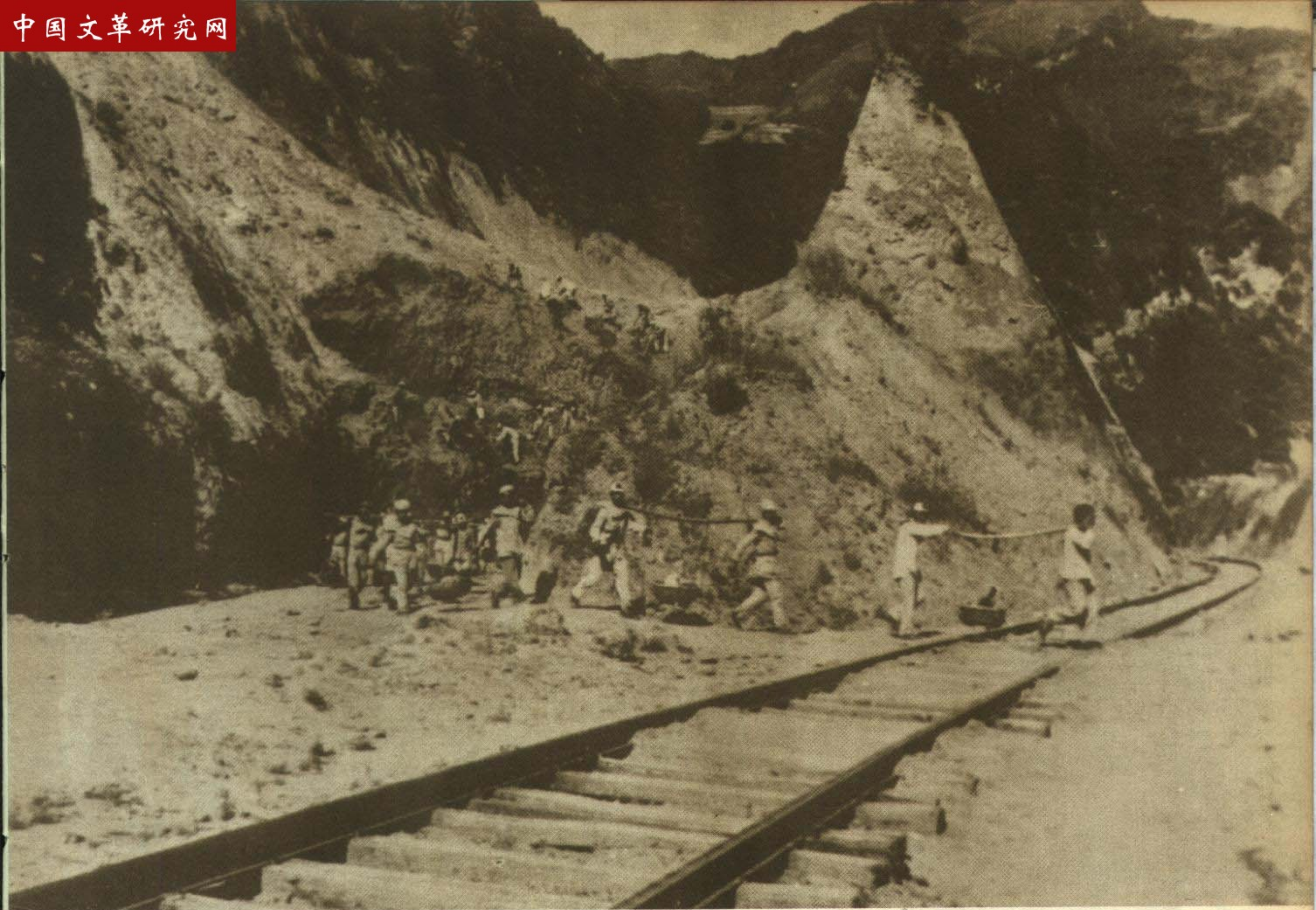
修築天寶鐵路的戰士們攀登高於地面數百公尺之陡山，劈坡以防塌方。
